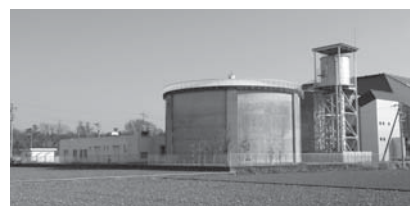
配水場では、ポンプで水を押し出しています
